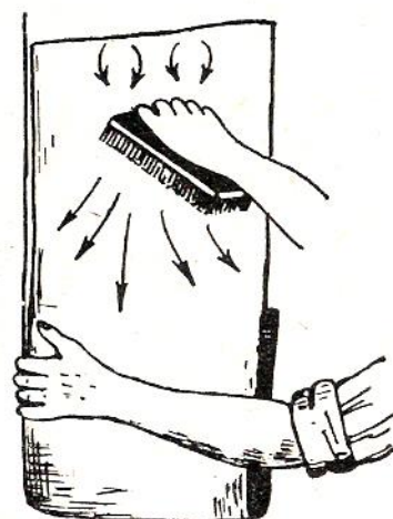
Netezirea fâșiei de tapet și îndepărtarea bulelor de aer
